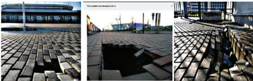
Рис. 3. Провалы тротуарной плитки вокруг стадиона ФИФА «Калининград – Арена» (2018 г.)
